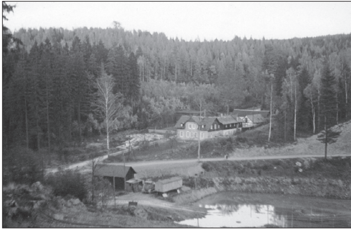
Foto: Max Rößler (1903-1976) HERBST 1971 Gründungsarbeiten zum Bau der Talsperre Falkenstein
