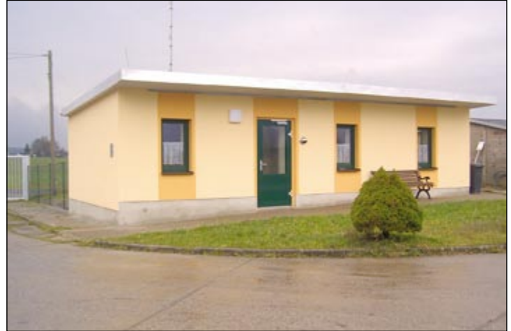
Sozialgebäude Bauhof (neu)
