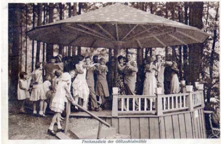
Freitanzdiele der Göltzschtalmühle
