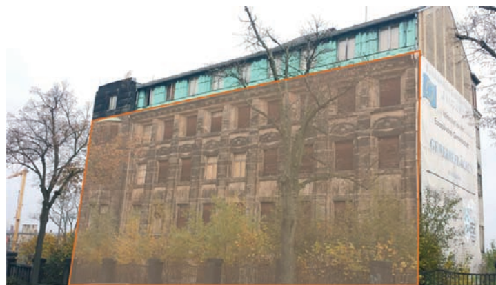
Zu erhaltender Teil der Fassade
