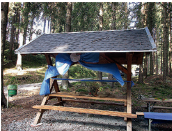
Foto LEADER-RM neue überdachte Sitzgruppe an den Reißfällen
