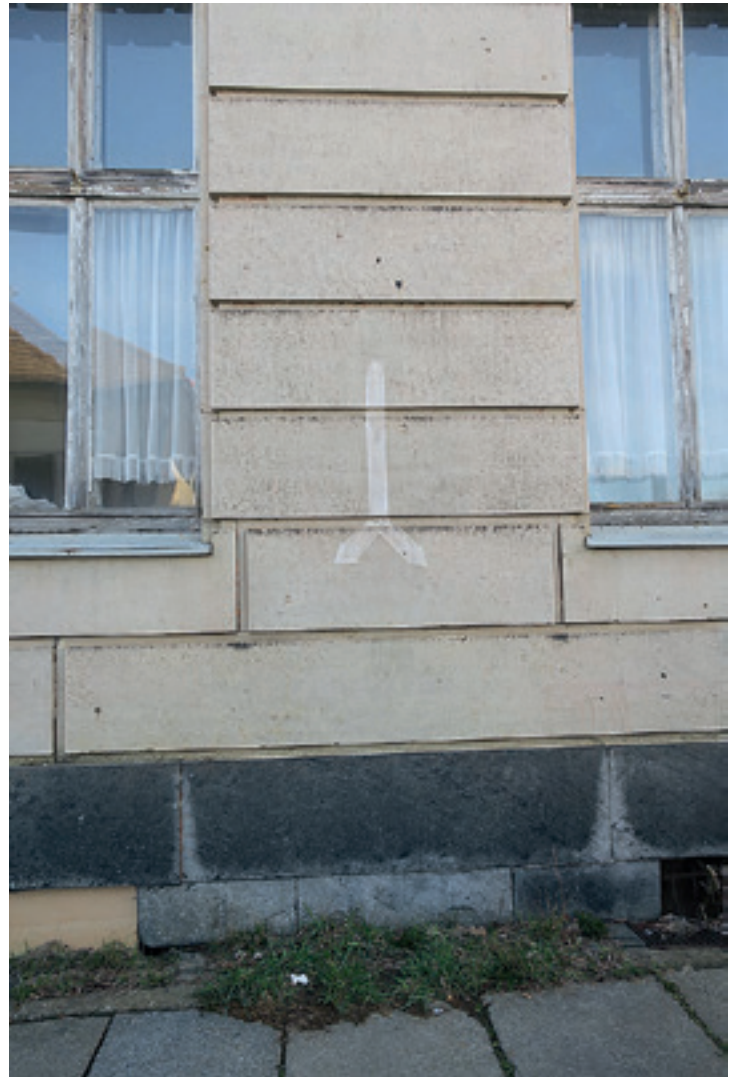
Andreas Rößler, 11. April 2021, Weißer Luftschutzpfeil an einem Haus in Falkenstein
