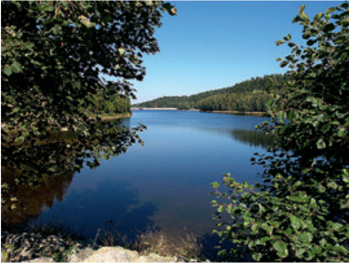
Talsperre Falkenstein Foto: Stadt Falkenstein/Vogtl.
