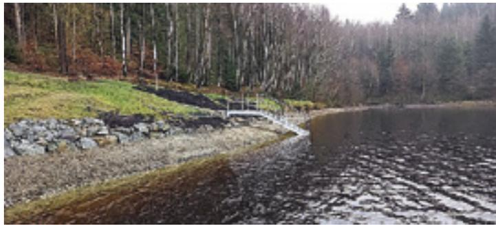
bacher Schlosserei Schultheiß gefertigt und aufgestellt. Über 9 breite und sicher begehbare Stufen, teils im Wasser liegend, können die Badegäste sicher in das kühlende Nass der Talsperre gelangen. Am Anfang der Treppe befindet sich ein Podest, was noch mit Platten belegt wird und als Abstellfläche
