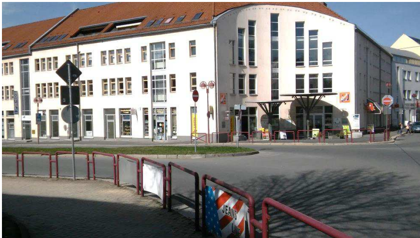
Foto 55: Straßenquerung im Bereich Auerbacher Straße / Dr.-Goerdeler-Straße durch Geländer erschwert
