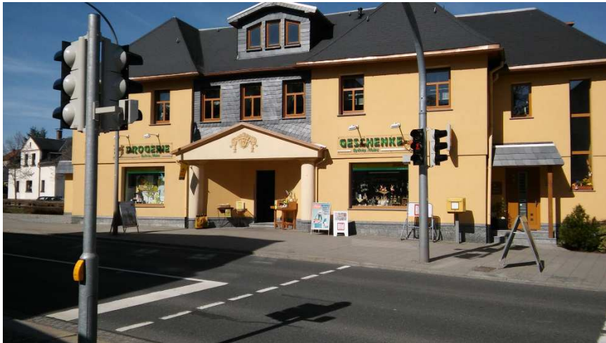
Foto 71: Drogerie und Geschenkeshop / gesicherter Überweg
