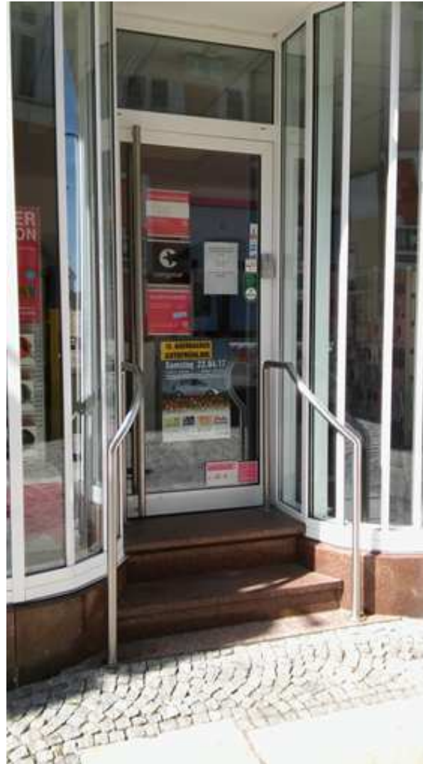
Foto 24: Treppenstufen im Eingangsbereich eines Geschäftes / Eingang für ältere Menschen und Rollstuhlfahrer nicht zugänglich
