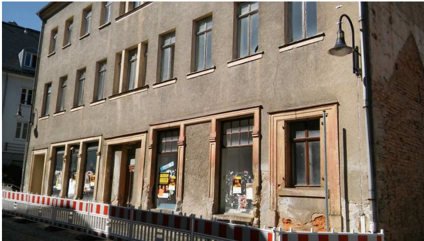
Foto 6. Einzige Potenzialfläche in der nördlichen Nicolaistraße
