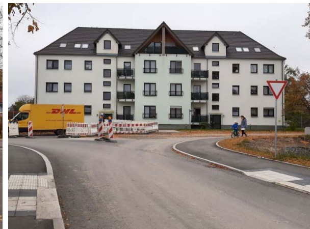
Abb. 13: Heinrich-Heine-Straße 18 a, b, Geschosswohnungsbau nördlich neben dem Tierpark
