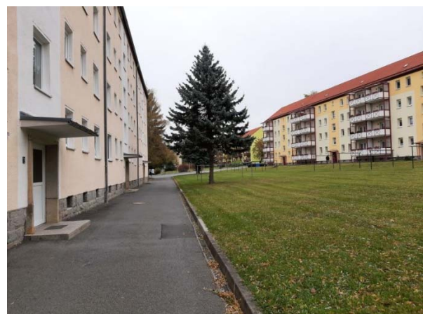
Abb. 11: Wohngebiet der Arbeiterwohngenossenschaft (AWO) mit Freifläche im Osten
