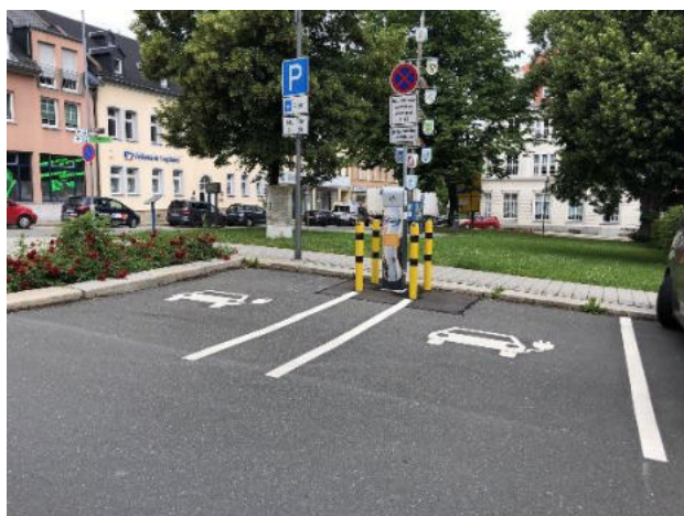
Abbildung 39: Ladesäule am Willy-Rudert-Platz
